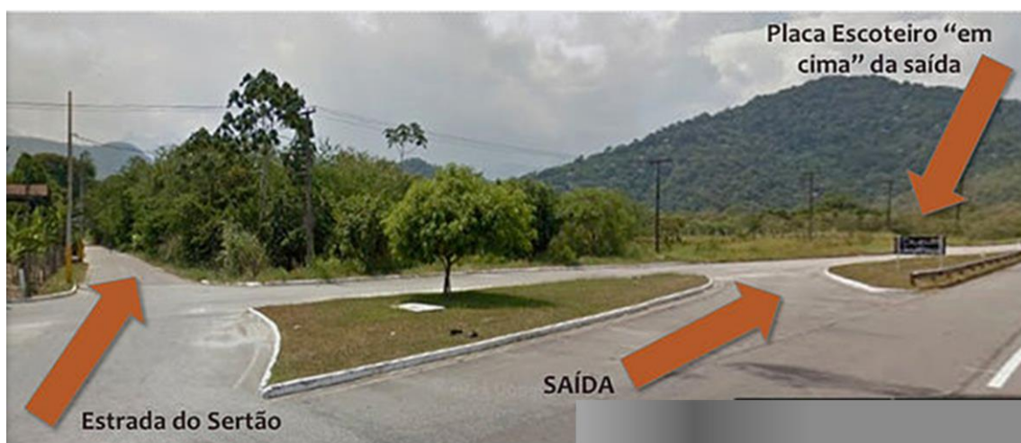
Figura 2 - Acesso à RPPN Campo Escoteiro Geraldo Hugo Nunes, pela BR 116. FONTE: Oenach na Taitiu
